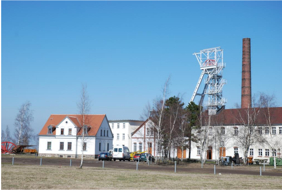
Zechengebäude des Forschungs- und Lehrbergwerks „Reiche Zeche“ der TU Bergakademie Freiberg
